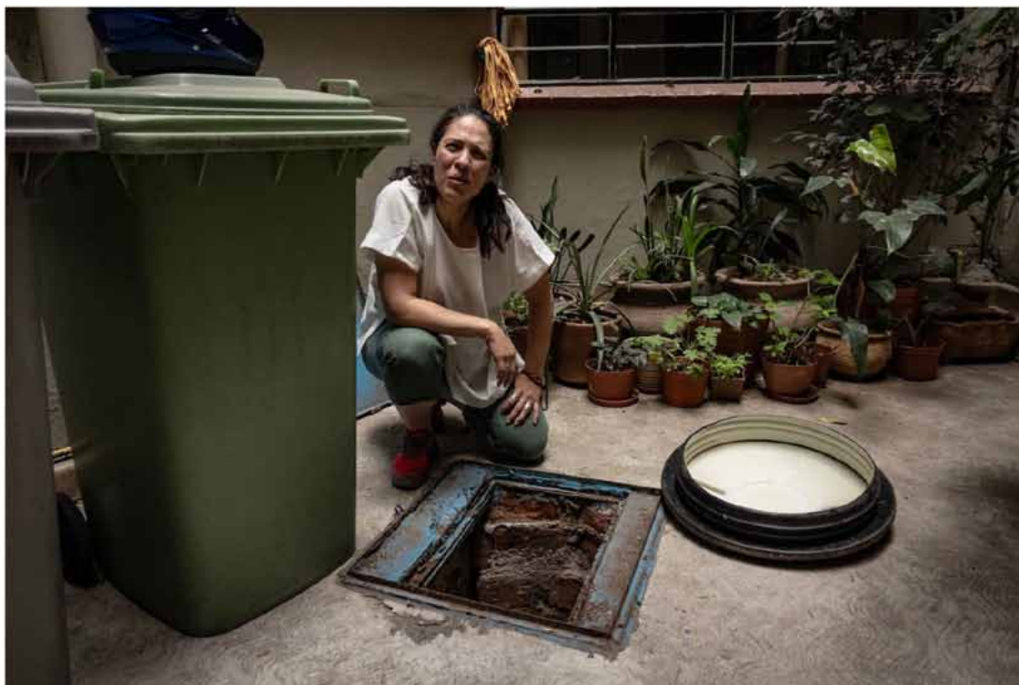
Lucina Leo, vecina de la colonia Del Valle, observa el agua contaminada del edificio en el que vive, el 10 de abril. Nayeli Cruz
